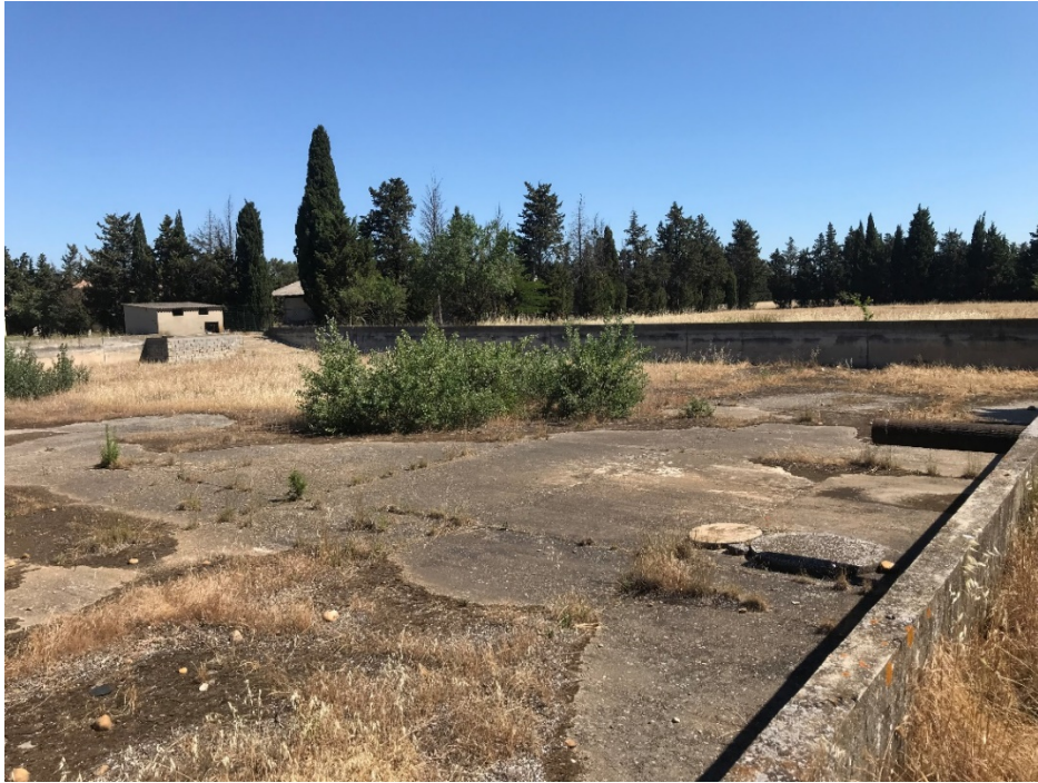
Photo 6 : ancien bassin utilisé pour le stockage de l'eau - Photo T&P 2019
