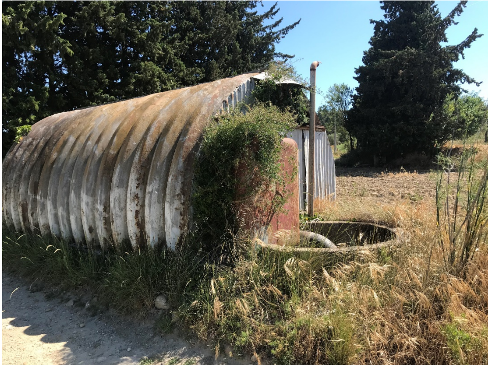
Photo 8 : pompe pour la prise d'eau au niveau du canal des Alpines - Photo T&P 2019
